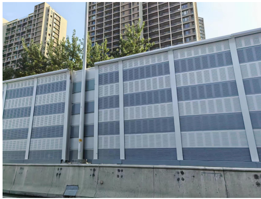
金地自在城段声屏障安装示意图
