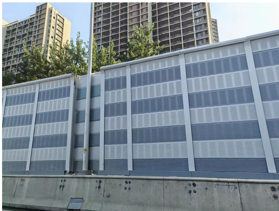
图 4-8 金地自在城一侧路段声屏障安装示意图
