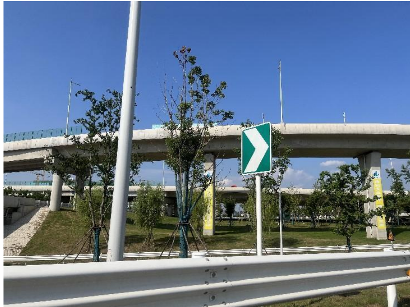
图 7-2 匝道两侧植被恢复现状图
